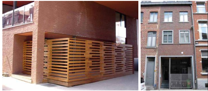
Geïntegreerde fietsberging bij nieuwbouw/renovaties 17
