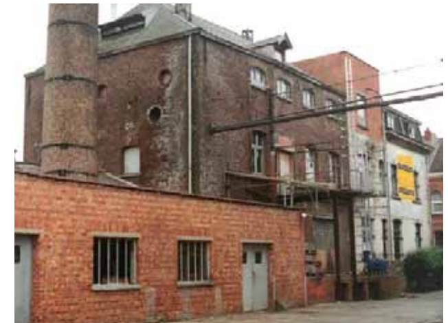
VROEGERE STROOPFABRIEK WAYLAND - vóór de renovatieproject bron: fotografie ÁRTER ©
