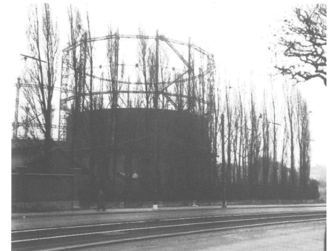
| FOTO VAN EEN GASHOUDER TE ESSEGHEM bron: CHAF - Comté de Jette - 1993/1994 Gazomètres ©
