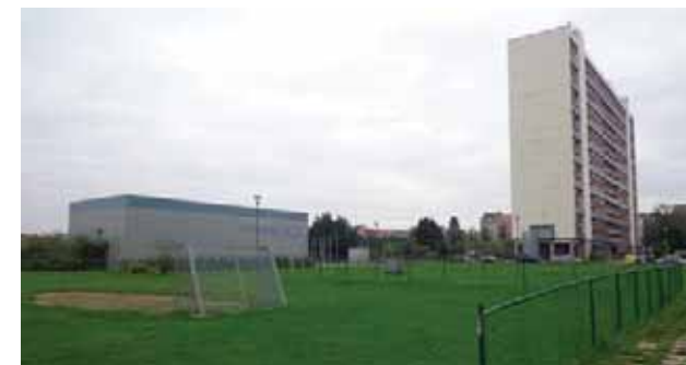
FOOTTERREIN EN PETANQUE SPORTHAL bron: fotografie Ártar ©
