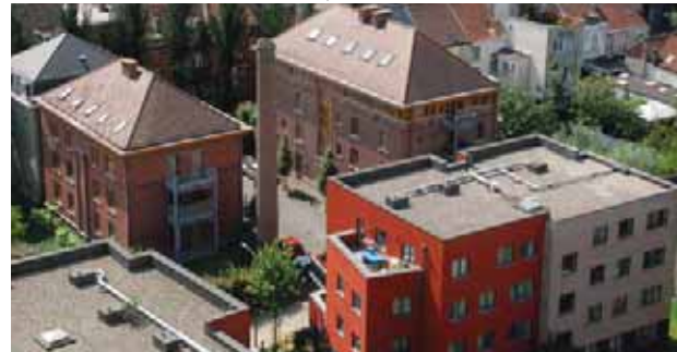
Renovatie van de vroegere stroopfabriek Wayland en gemeentelijke woningen bron: fotografie ARTER ©
