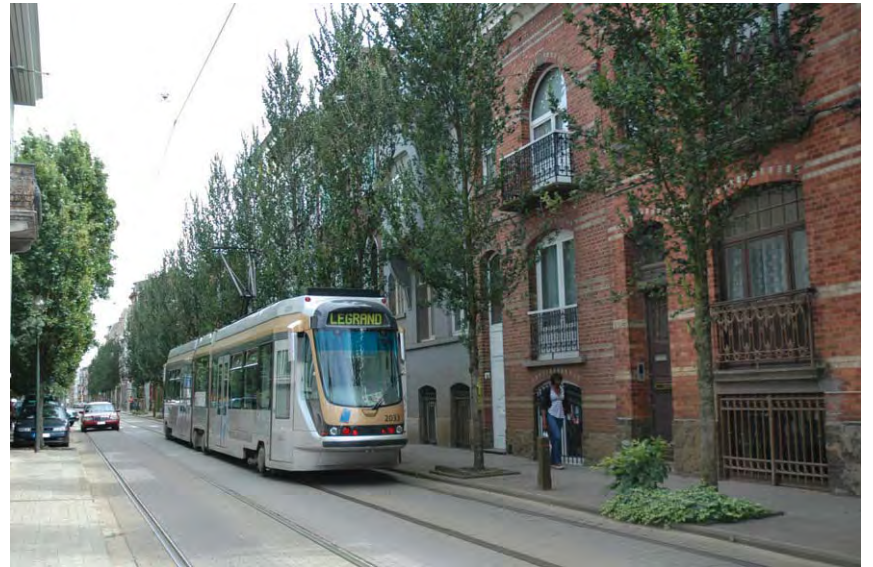
Les voies de tram dans la rue Lahaye ne sont plus adaptées aux nouveaux trams.
